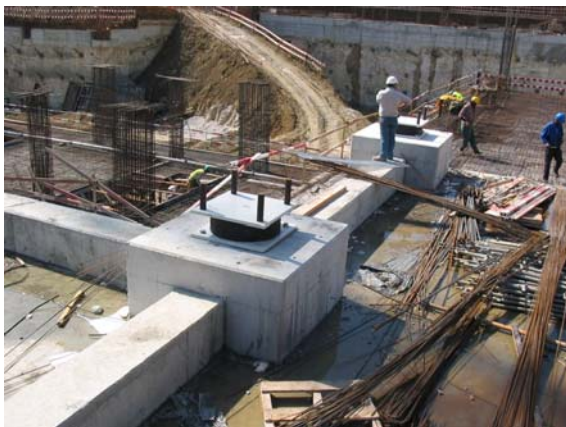
FIG. 7. Isolatori sismici durante l'installazione.
