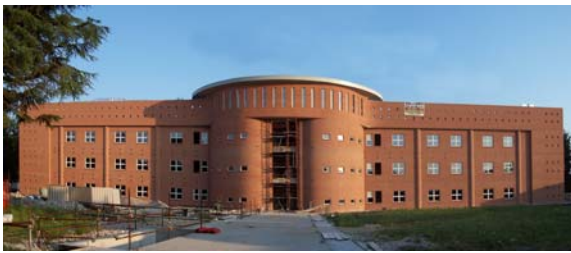
FIG. 1. Il nuovo edificio dell'Ospedale Gervasutta di Udine
