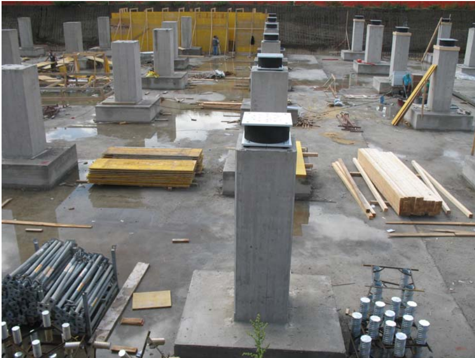
FIG. 11. Isolatori sismici durante l'installazione (Ospedale del Mare, Napoli).
